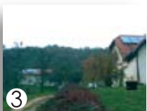
3 Aprey Panneaux solaires thermiques et photovoltaïques Samedi 23 octobre à 9h
